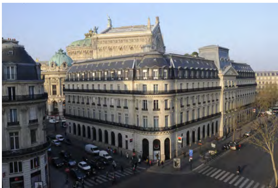
Exterior view of the 29 boulevard Haussmann, in Paris. © Jean-Marie Cras / Archives historiques Société Générale
